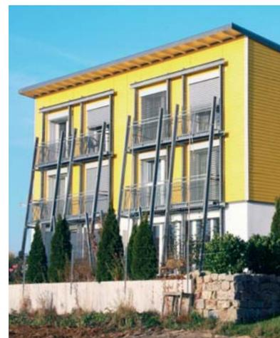
Passive Solarenergienutzung: Große Fenster und eine entsprechende Ausrichtung liefern kostenlos Wärme.
