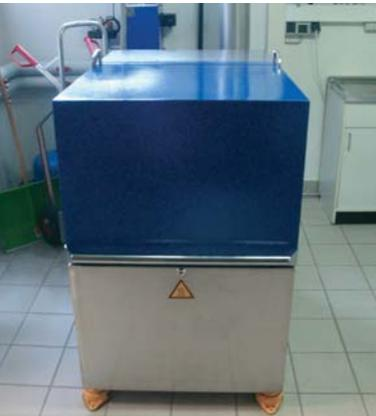
Kellerkraftwerk: Strom und Wärme in einem.
